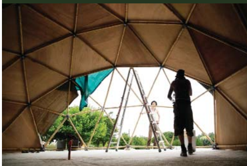
"Dôme de bambou" (temporaire) en construction.
